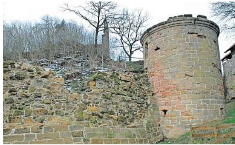
... erste Bauabschnitt ist nun abgeschlossen: Sicher und saniert präsentiert sich der Wehrturm mit angrenzender freigelegter Schildwand sowie historisches Füllmauerwerk im oberen Teil.
