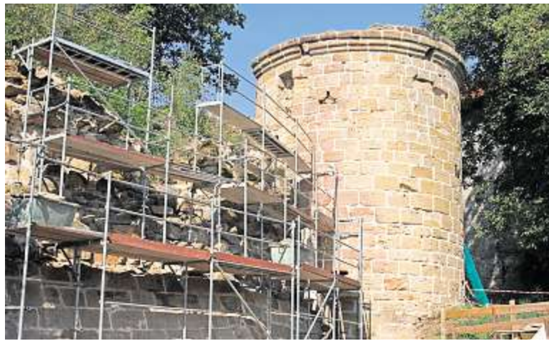
Neue Attraktion ist die freigelegte Ringmauer der Kernburg, die sich an den Hang lehnt – einmalig weit und breit. Schön nachzuvollziehen ist an ihr der ursprüngliche Verlauf sowie die seinerzeit übliche Bauweise. Dieser ...
