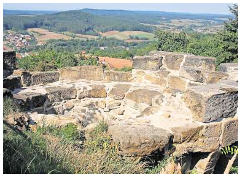
Insbesondere der Grasbewuchs am Kopf der Wehrtürme hatte die Steine gelockert und zu einer Gefahr für Besucher werden lassen. Dieser Turm ist bereits freigelegt, die Spalten sind geschlossen.
