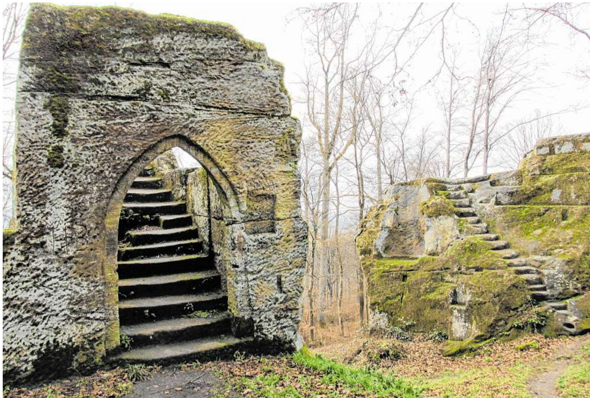
Die Burg Rotenhan wurde auf diesen großen Sandsteinblöcken am Hang des Baunachtals errichtet. Die beschlagenen Blöcke dienten als Eckpunkte der Burganlage.
